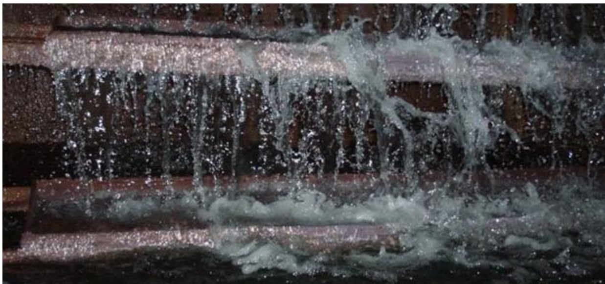
Ittningstrappe Ørslev Vandværk
